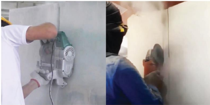
สามารถใช้เครื่องเซาะร่อง หรือลูกหมูกรีดผนังได้
