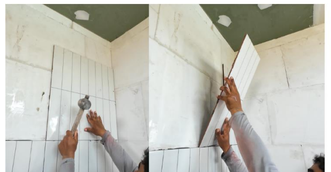
อิฐอัดแรงNK สามารถปูกระเบื้องภายในห้องน้ำได้
