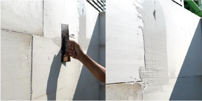
สกิมทั้งผืนและเก็บรอยต่อด้วยปูนกาวก่ออิฐอัดแรงNK
