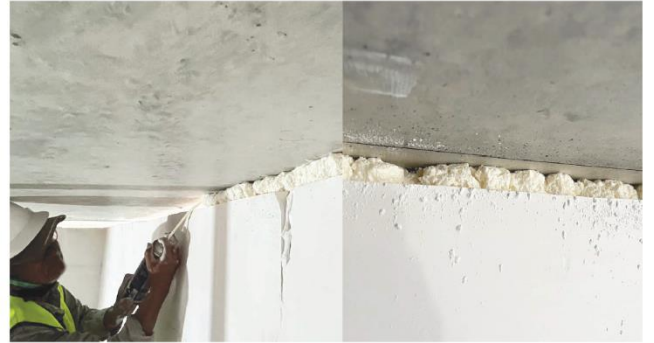
เก็บช่องว่างใต้ท้องคานด้วย PU FOAM
