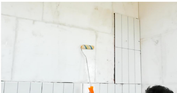
ใช้น้ำยา Rocky Coat ทาเพื่อกันซึม
